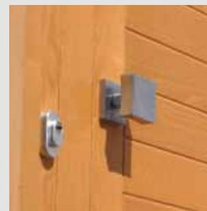
La robustezza è garantita sia dalla sezione del legno utilizzato sia dal tipo di ferramenta montata. **Tutti gli spigoli sono arrotondati** per dare un maggior supporto alla verniciatura ed una più raffinata linea al serramento.
